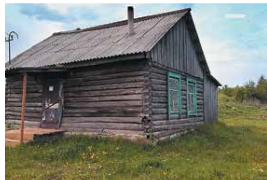
В селе Озеряне потоп полностью разрушил медицинский пункт. Так он выглядел до потоп
