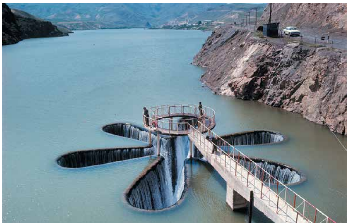
Слив воды на плотине Шамбской ГЭС (Воротанский каскад ГЭС)
