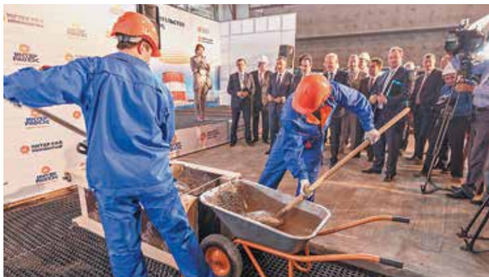
Торжественная церемония возобновления строительства Затонской ТЭЦ
